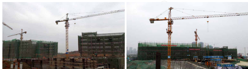
▲ 园区在建学校施工现场
