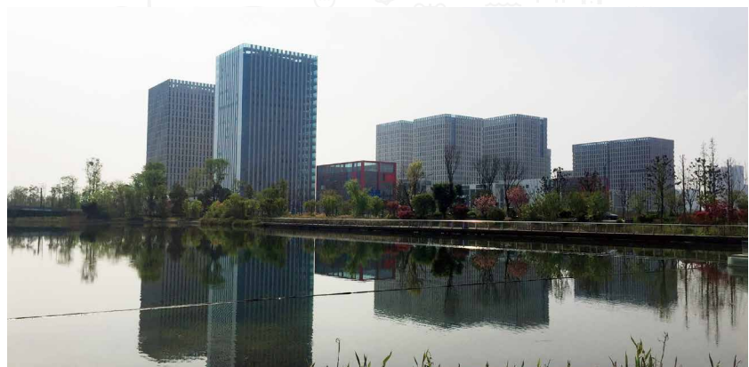
▲新一代信息技术孵化园建设现场
