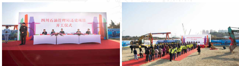
▲ 开工仪式现场
