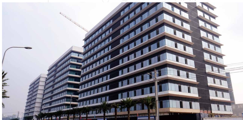
▲生物医药创新孵化园建设现场
